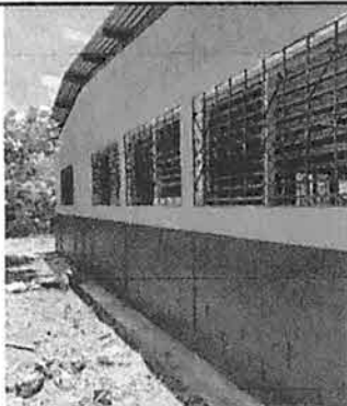
Foto 11: Reemplazamiento de Cuneta fundida de 60 cm X 0.10 cm de espesor.
