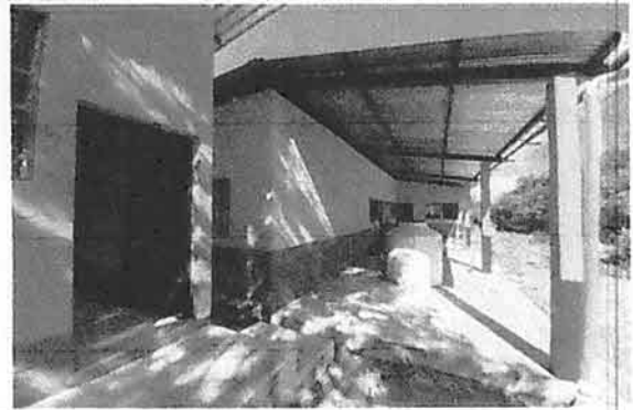
Foto 10: Instalación de Canales y bajada de aguas.
