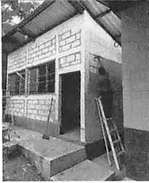
Foto7: Colocación de Pintura en Establecimiento Interior y Exterior
